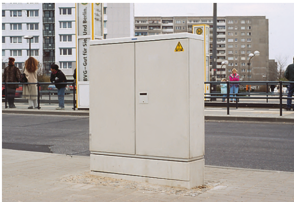
Freiland-Verteilerschrank
